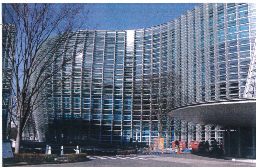
● 国立新美術館 施工完了
